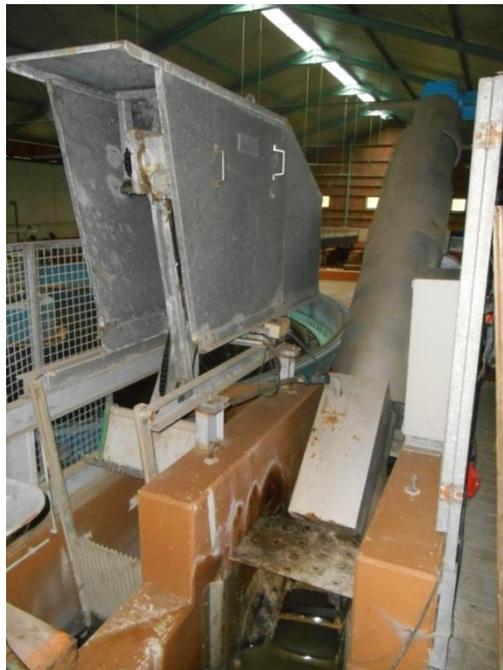
Abbildung 1: Feinrechen (rechts) und Notumlauf Rechenanlage (links)
