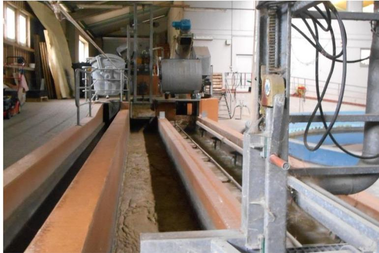
Abbildung 2: Belüfteter Sand- und Fettfang
