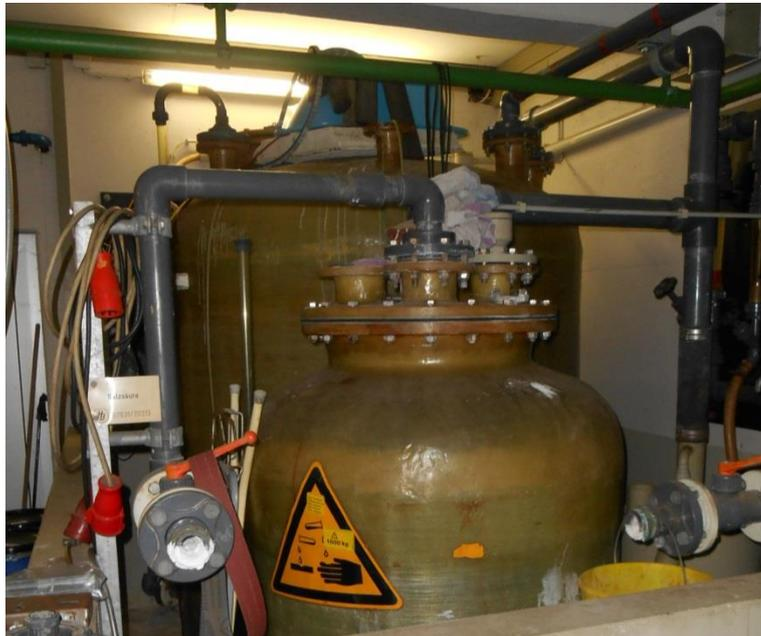
Abbildung 5: Phosphatelimination: Vorratsbehälter Fällmittel
